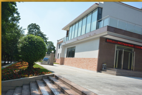
新投入使用的化灌楼
